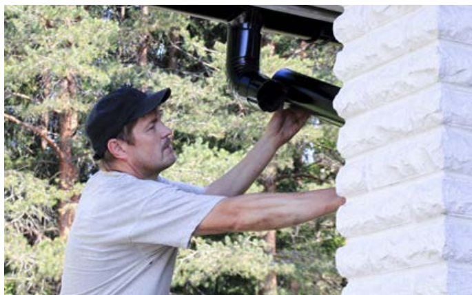
Syökytorven asennus ammattilaisen ottein.
